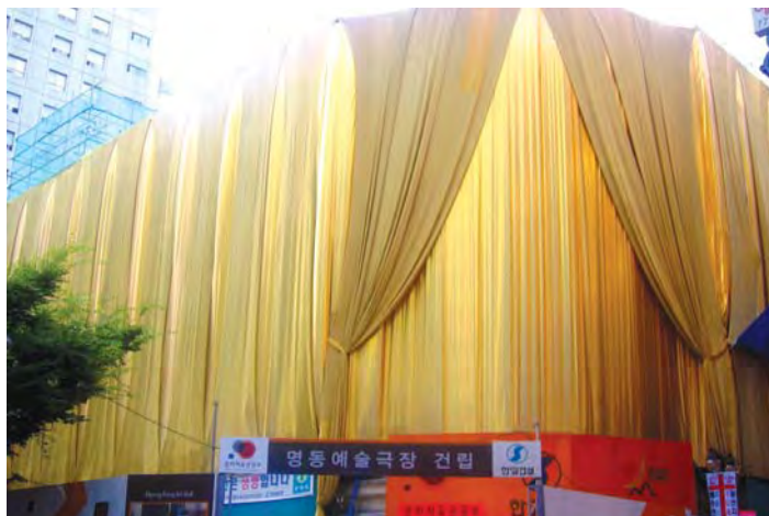
건립 중인 명동예술극장
